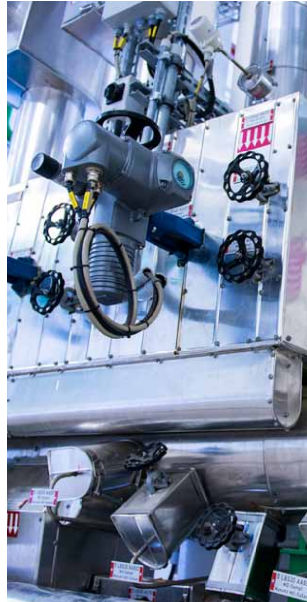
Stromturbine und Luftkondensator
