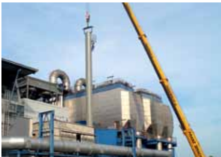
Schlot für neues Kesselhaus
