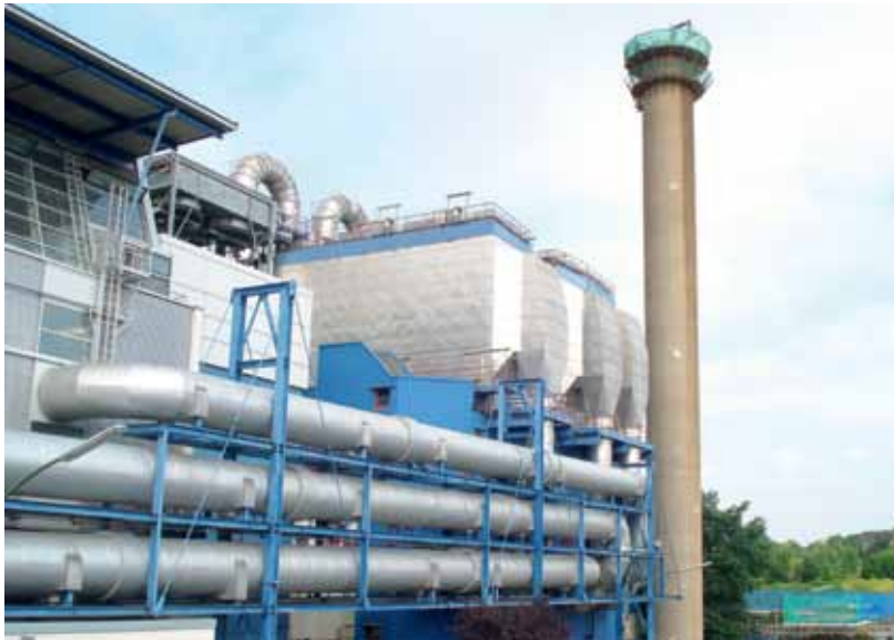
Abriss des alten Schlots
