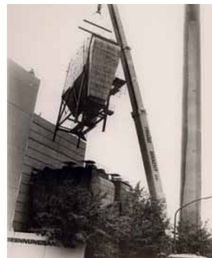
Umsetzen des E-Filters
